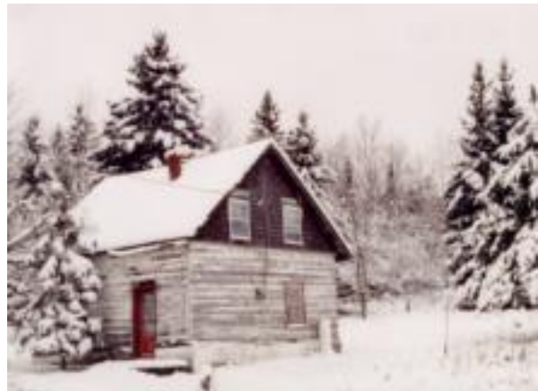
Bureau de poste, 1922 (Source : Municipalité de Duhamel)
